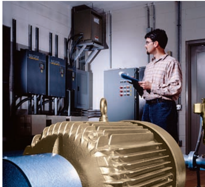
Un motor Super-E y un Control Inversor de Baldor proporcionan eficiencia energética superior y un mejor control de procesos a una instalación municipal de tratamiento de agua.
